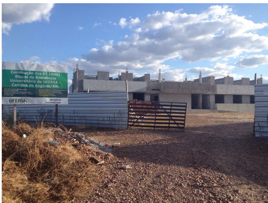
(construção da Residência Universitária em andamento)
