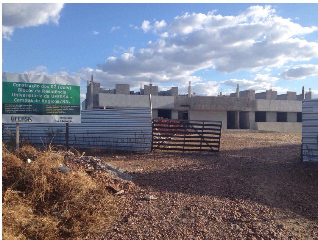
(Residência Universitária: obras em andamento 15.02.2016)
