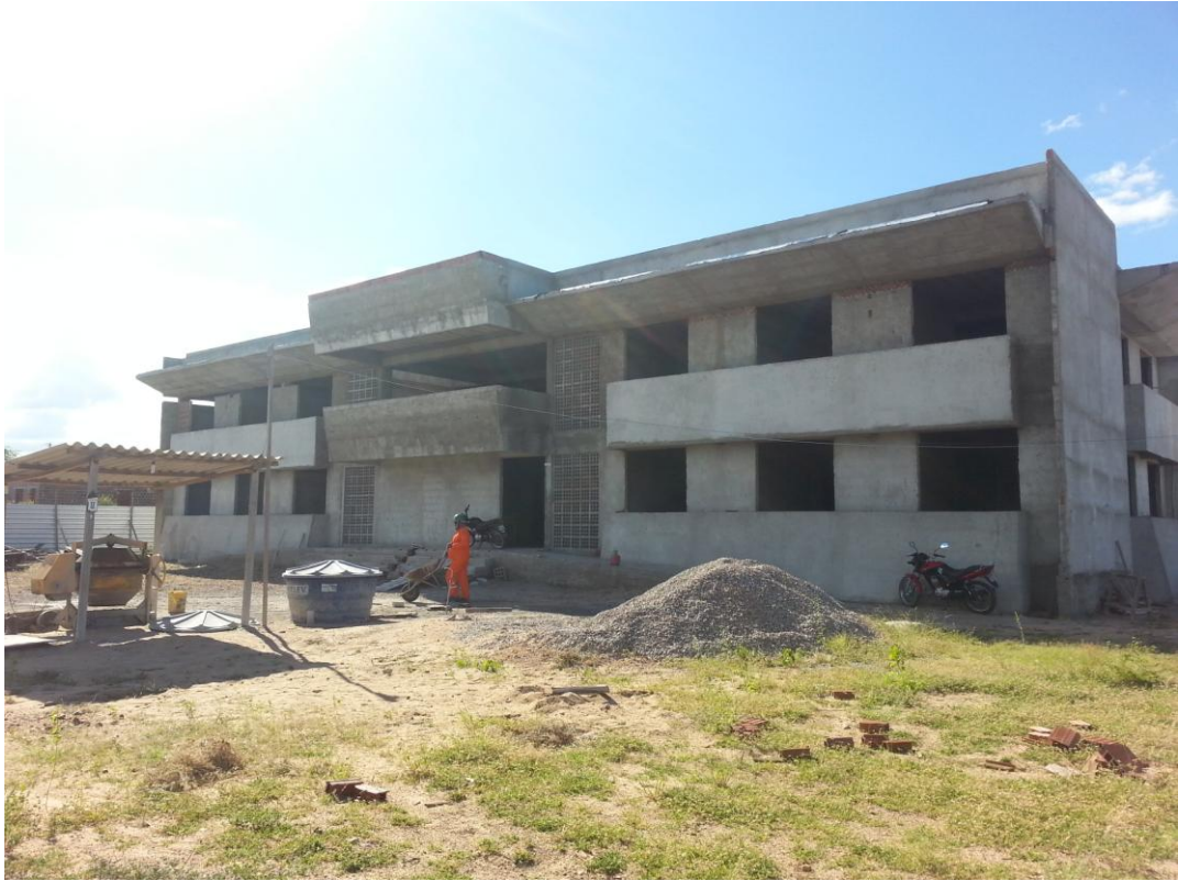
(Residência Universitária: fachada da ala feminina - obras em andamento 15.02.2016)
