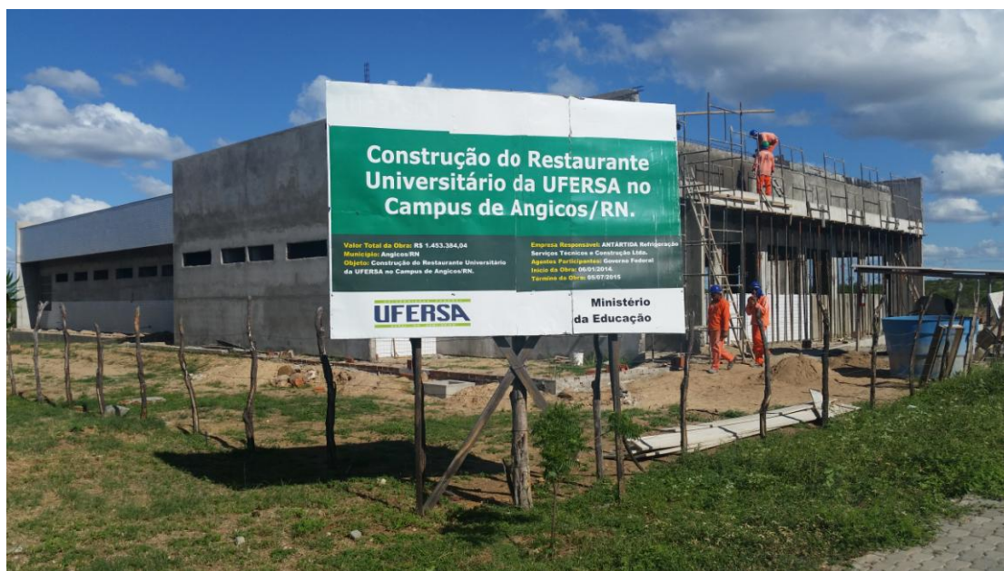
(Restaurante Universitário: obra em andamento 15.02.2016)
