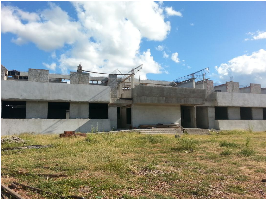
(Residência Universitária: fachada da ala masculina - obras em andamento 15.02.2016)
