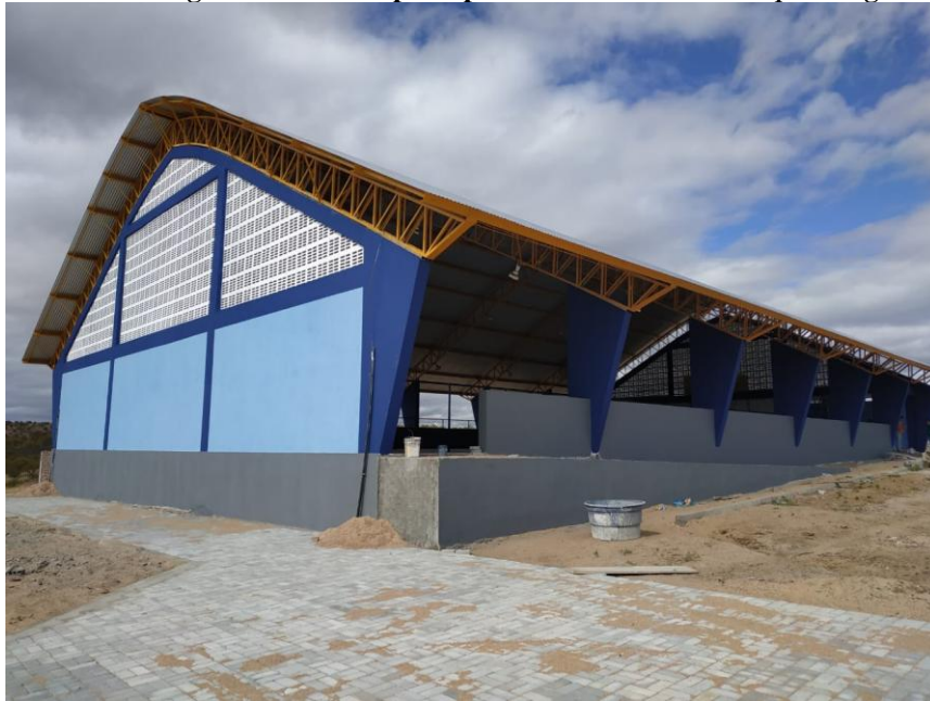
Imagem 1 – Ginásio poliesportivo da UFERSA Campus Angicos
